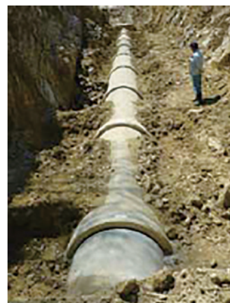
写真 パイプラインの試掘
