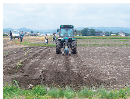
写真3 弾丸暗渠の施工
