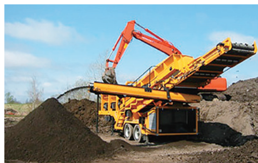
写真 稼働中のスタースクリーン
