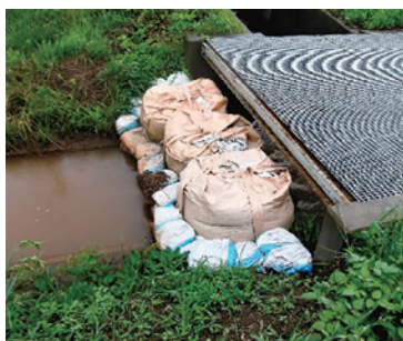
土のうによる用排分離
