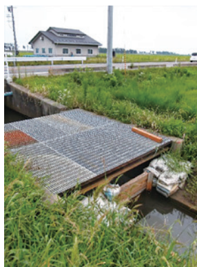
堰板による用排分離
