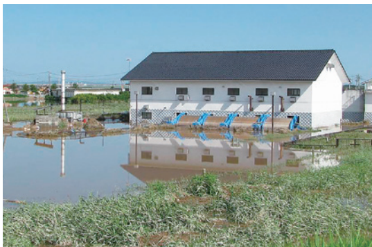
写真 水没した米袋排水機場
