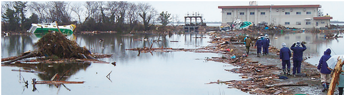
写真1 破壊され瓦礫に埋まる排水機场上流水路
