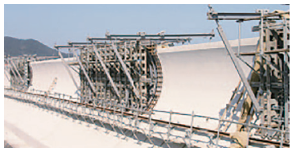
写真2 移動型枠工法
