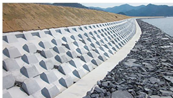
写真2 二次製品による海岸工
