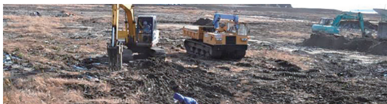
写真 農地の瓦礫除去作業
