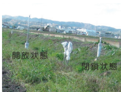
写真2 開放状態の水閘
