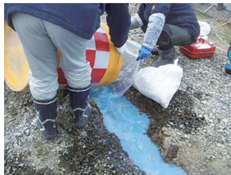
写真 亀裂への石灰水の注入
