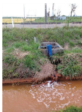
水中ポンプによる排水
