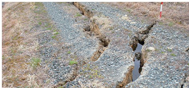
写真 劣化が進んで水が溜まり崩壊した地震災害の亀裂
