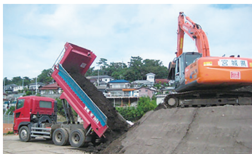
写真2 搬入される津波堆積土
