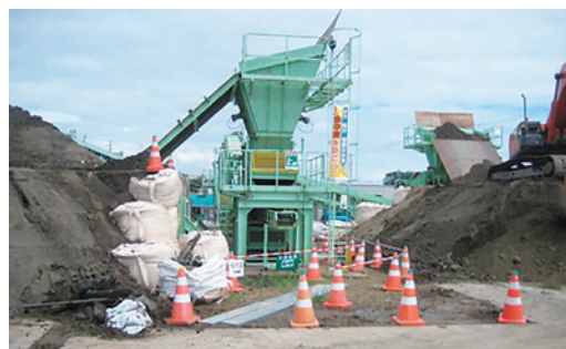
写真3 瓦礫除去プラント
