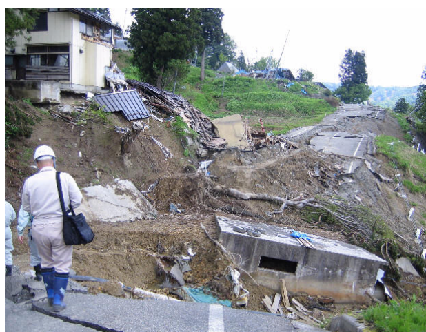
大規模な崩落で寸断された集落内の道路／主要地方道・栃尾山古志線（05. 05. 23・旧山古志村池谷）
