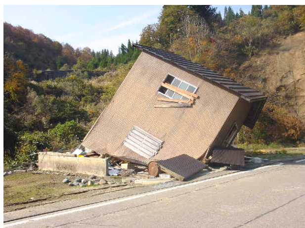
2階を物置にしていた納車／集落内にはいと破壊された農舎は多い（川口町田麦山小高周辺 04. 11. 06）
