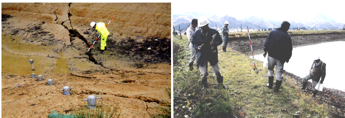
写真 県職員によるため池の緊急点検
