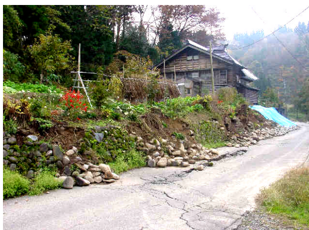
崩れた石垣：裏山に亀裂があり、住宅脇に見える樺の古木が倒れかかる可能性があった（小千谷市小土山周辺 04. 11. 06）
