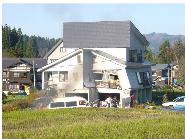
一階が座屈した震源地近傍の住宅：川口町田麦山（04. 11. 23）
