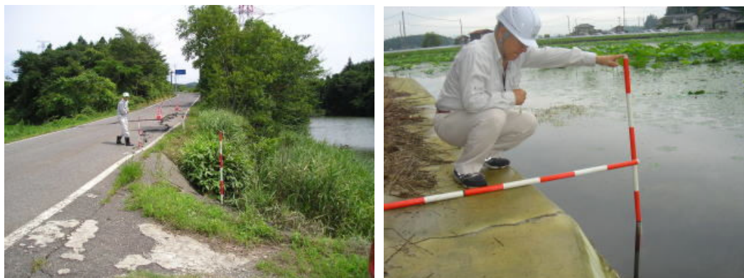
写真 中越沖地震直後のため池の被害実態調査
