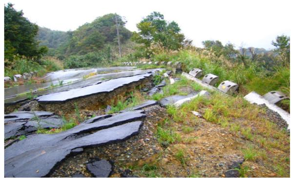
写真2 切り盛り度の境界で路盤が滑落した道路
