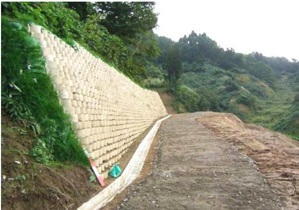
写真1 ジオセル工法による擁壁
