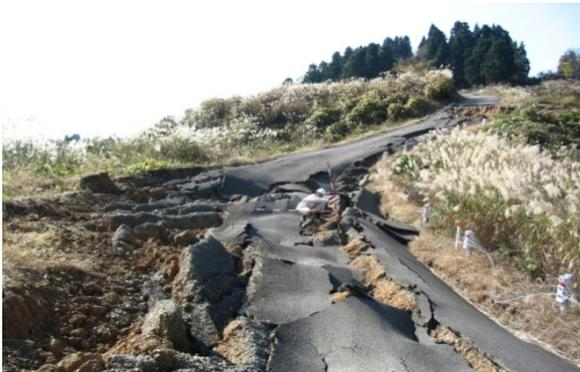
写真5 アスファルトが飴のように崩壊した道路
