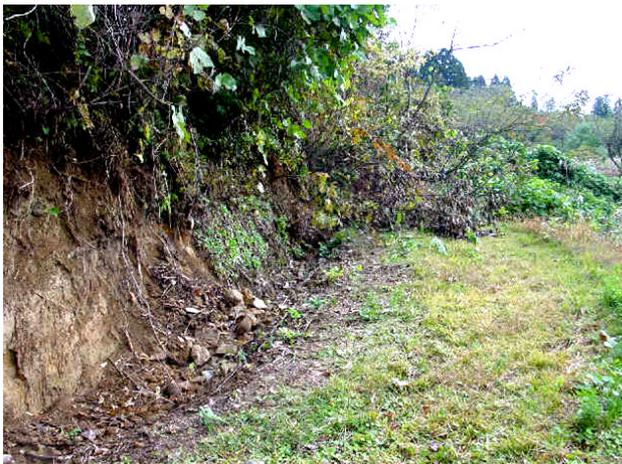
ここで行き止まり／切り土によって造った道路は路盤は安定しているが、崖の崩壊が起きている／04. 10. 31／小千谷市四ツ子周辺
