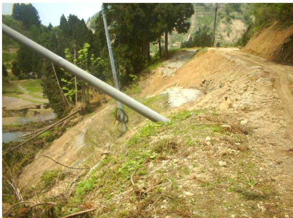
写真3 道路山側斜面を削り盛土で応急対応
