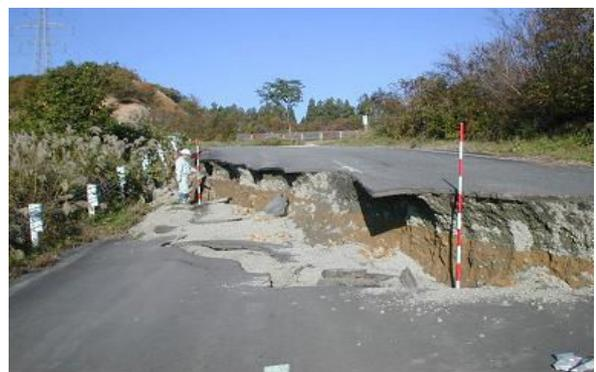
写真6 切り盛り度の境界で段差が発生した道路
