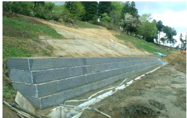
写真 鋼製擁壁工法による施工の完了
