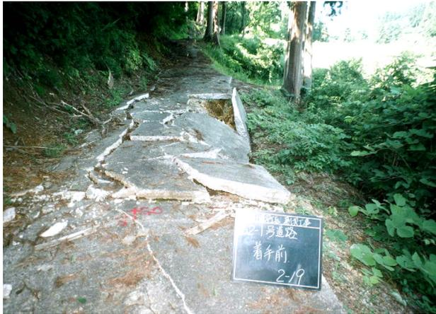
写真1 路体の崩壊による舗装版の被災
