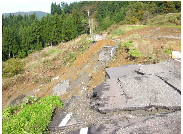
路盤全体が崩落した幹線道路／路盤は谷底まで一気に滑り落ちていく／04. 10. 31／小千谷市冬井周辺
