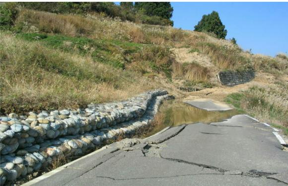
写真7 地すべりと共に崩壊した道路
