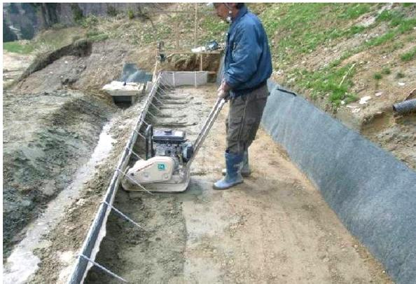
写真 鋼製擁壁の中詰土転圧
