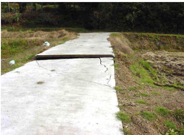
コンクリート舗装の道路が地滑りを起こし、継ぎ目部分で段差を生じている／04. 10. 31／小千谷市戸屋周辺
