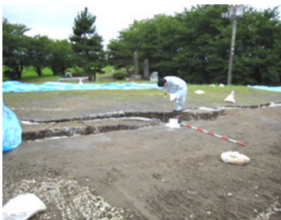
写真1 左岸堤防の亀裂
