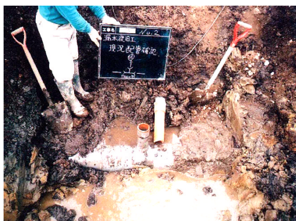
写真2 接続部位の管路破損確認
