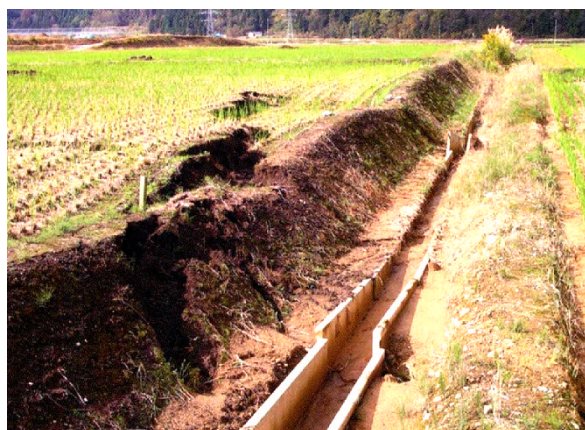
写真1 三仏生地区の被害状況
