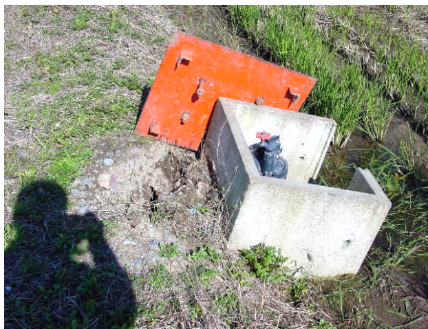
自動給水柱柵の傾斜／給水柱自体の被害は目視では分からない／04. 10. 29／小千谷市小栗田周辺
