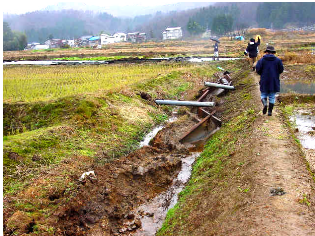
排水路に突き出した塩ビの集水渠／排水路は埋没している／04. 11／小千谷市両新田周辺
