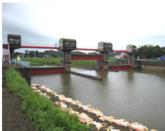
写真2 現地立会操作（中央ゲート全開） 左岸堤外地を大型土嚢で補強
