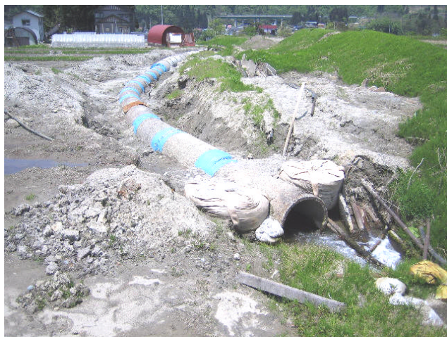
液状化で破壊されたパイプラインが農地内に露出している／05. 05. 21／川口町和南津
