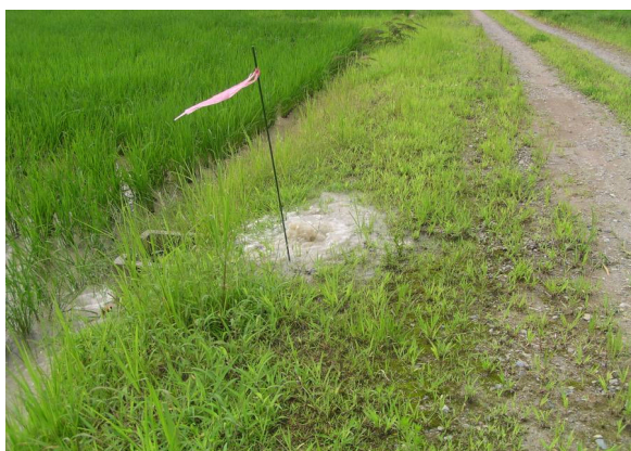
用水が噴き出している箇所には速やかに旗を立てる (ポンプが止まると意外に場所が分からない)
