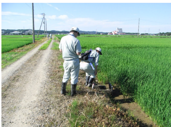
写真 パイプライン破損の現地調査(柏崎市 2007. 07)
