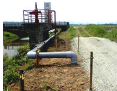
刈羽中部 第4号揚水機場 仮設ポンプ、配管設置図
