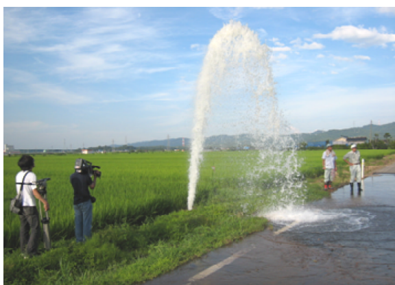
破損部から勢いよく吹き出した用水
