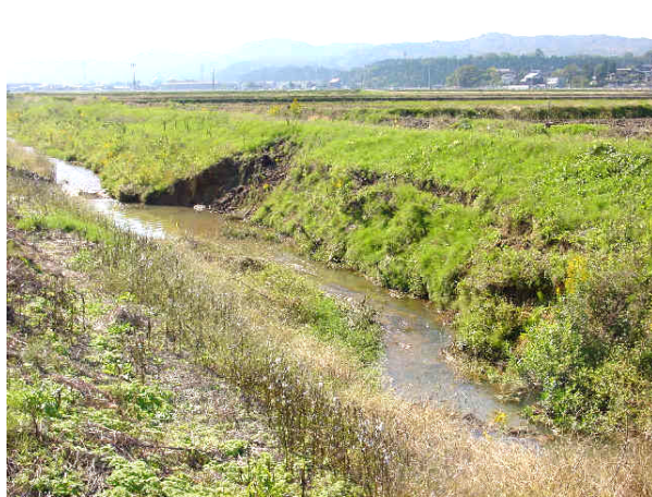
幹線排水路の法面崩壊／04. 10. 29／小千谷市高梨周辺
