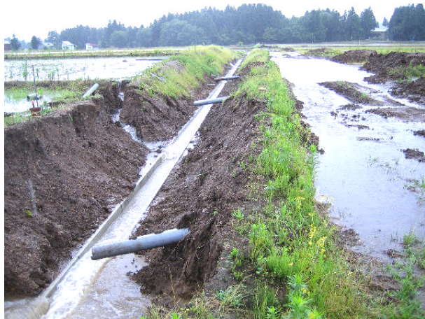
豪雨によって復旧した排水路が再び水害を受けようとしている／05. 06. 28／小千谷市両新田周辺
