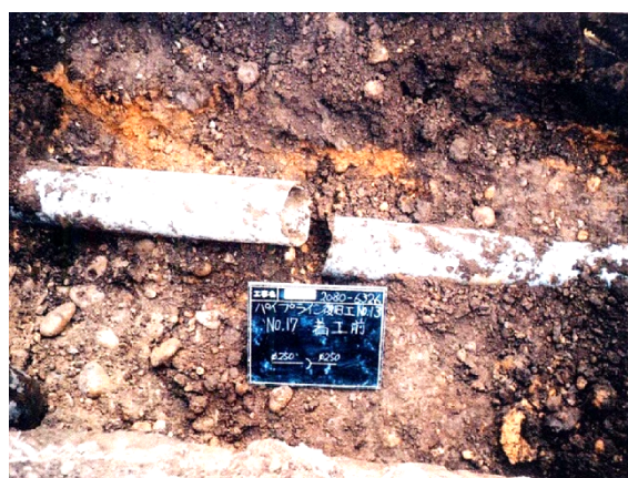
写真3 道路面下の管路の破断
