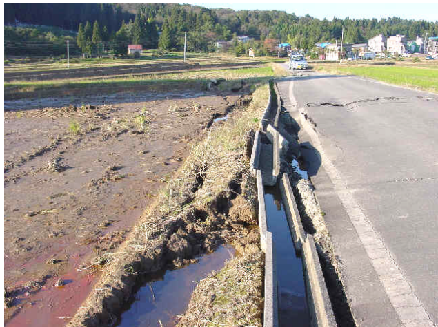
支線用水路の崩壊／改修は道路と一体的に進める必要がある／04. 10. 29／小千谷市両新田周辺
