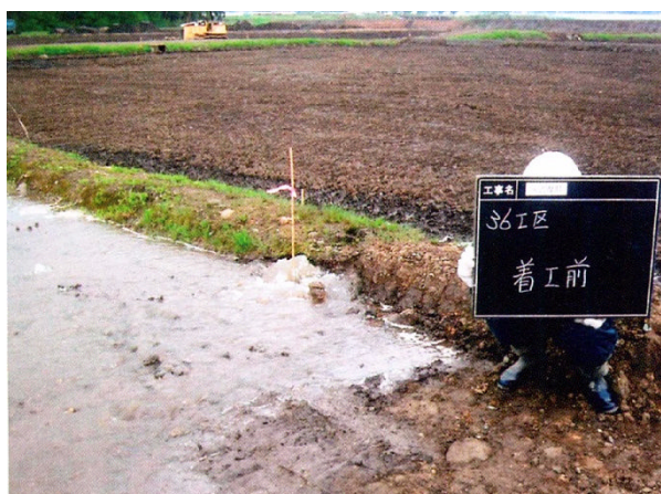
写真 通水時の漏水状況(中越地震)
