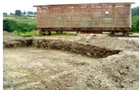
曳き屋工法による上屋の移動
