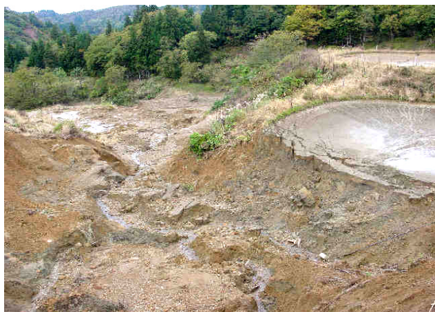
著しい場合には地震による破堤は地域の基盤を根こそぎ流し去った／池は半分消滅し、農道も押し流し、巨大なガリができています／下流のため池や農地は土砂流で破壊され、埋没した／04. 10. 31／小千谷市池ノ平周辺
