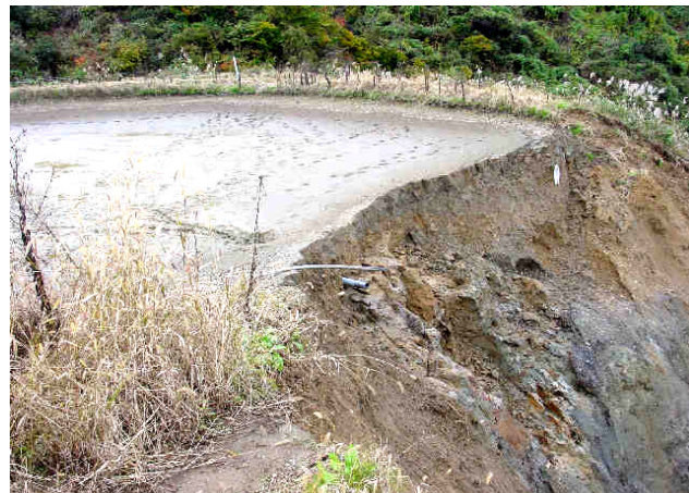
流亡したため池の断面／04. 10. 31／小千谷市池ノ平周辺
