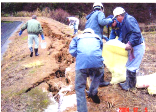
写真1 堤体亀裂部への石灰の流し込み(旧栃尾市)
