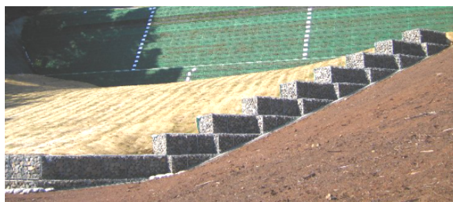
写真 押さえ盛り土の安定化には排水対策が大切(蛇籠による排水対策)
