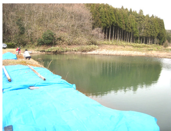
写真2 能登半島沖地震(07.03)では用水はできる限り確保する工夫が行われた(灌漑期直前)
