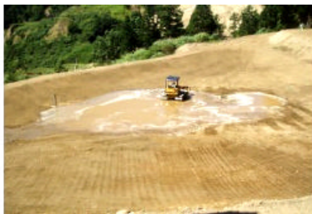
業者は手慣れた方法で野池を復旧していった
