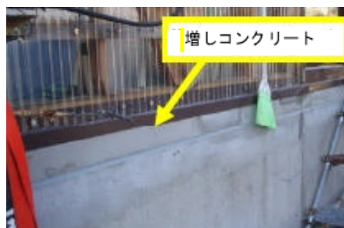
コンクリートによる水槽の補強
