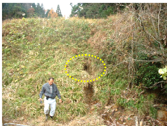
写真3 パイピングによる浸出水
