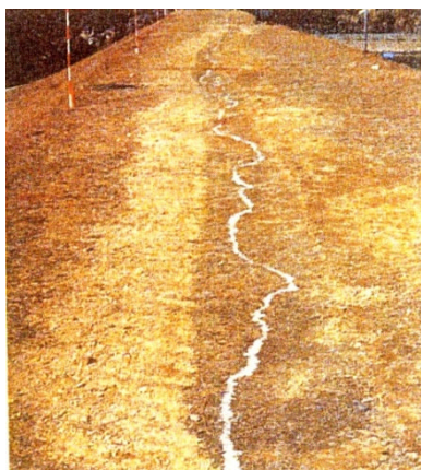
写真 金城池の堤体天端の亀裂
