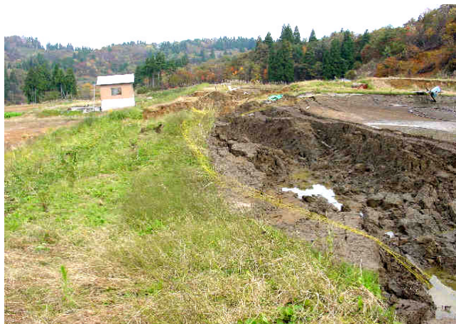
堤防の地滑りによる巨大な亀裂／溜め池は地区の最上部にあり堤防の法面も大きい／04. 11. 03／川口町相川
