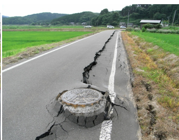
浮上したマンホールと埋設管渠に沿った沈下／ 07. 07. 20／柏崎市（中越沖地震）
