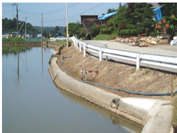
写真 仮復旧された集落排水施設のマンホール
