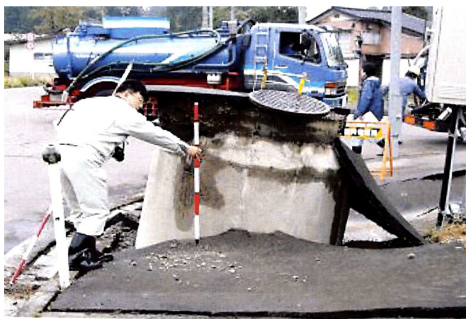
浮上したマンホール／04. 10／柏崎市
