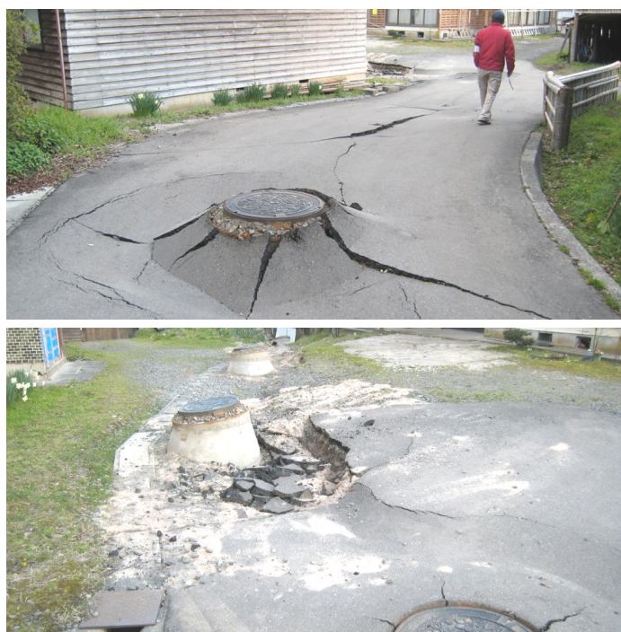
液状化による噴砂と浮上したマンホール
