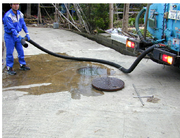
写真 バキューム車による汚水排除
