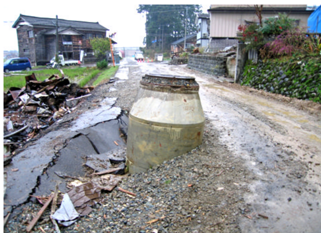
写真1 市町村道に埋設されたマンホールの浮上 (アスファルト舗装が飴のようになりマンホールが突きだしている)
