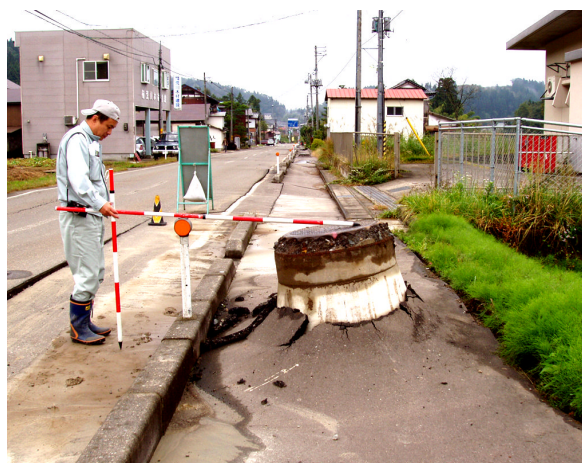
写真2 液状化による歩道に埋設された管路の被害
