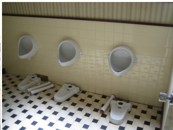
破壊されたままに放置された集会所のトイレ／ 05. 08. 31／小千谷市南河頃
