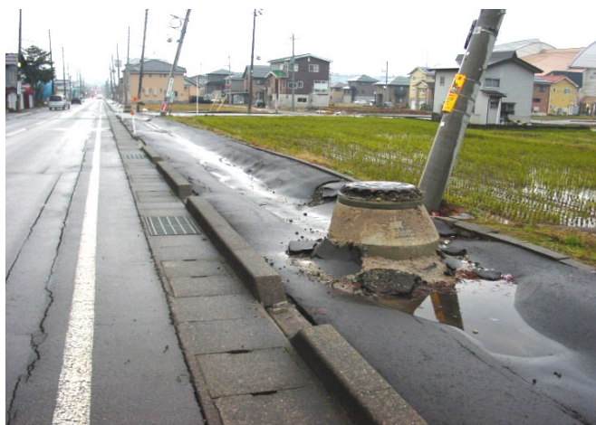
浮上したマンホールと埋設管渠に沿った沈下／04. 12. 11／ 小千谷市
