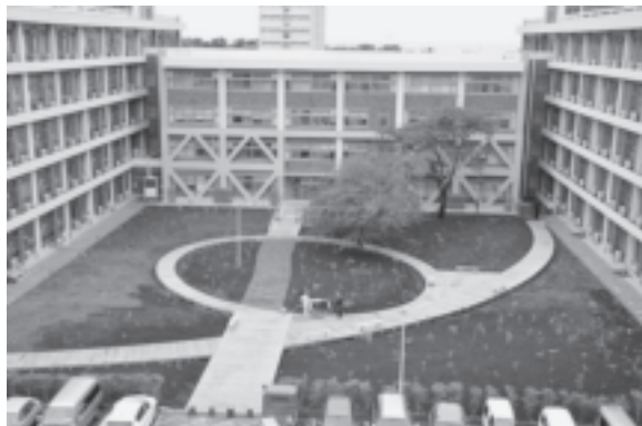
写真13：中庭の竣工俯瞰写真
