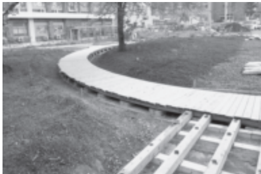
写真6：ボードウオークの施工
