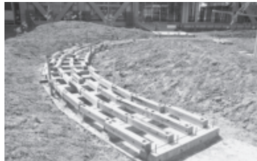
写真5：ボードウオークのコンクリート基礎工事
