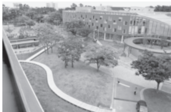
写真12：前庭の竣工俯瞰写真
