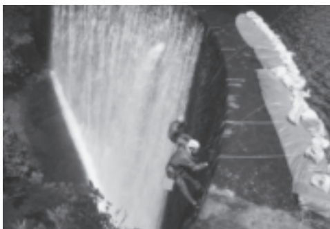
土木技術者と地質技術者がお互いの専門性を活かし連携して砂防堰堤の老朽化調査を実施している様子
