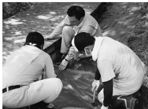
防草シート敷設
