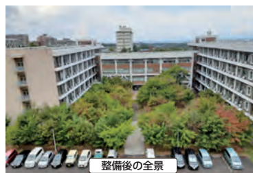
整備後の全景
