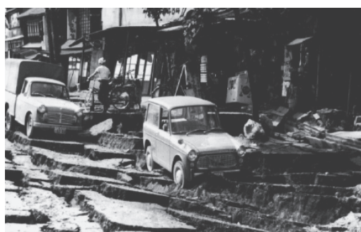
藤見町公衆市場前の地割れ
