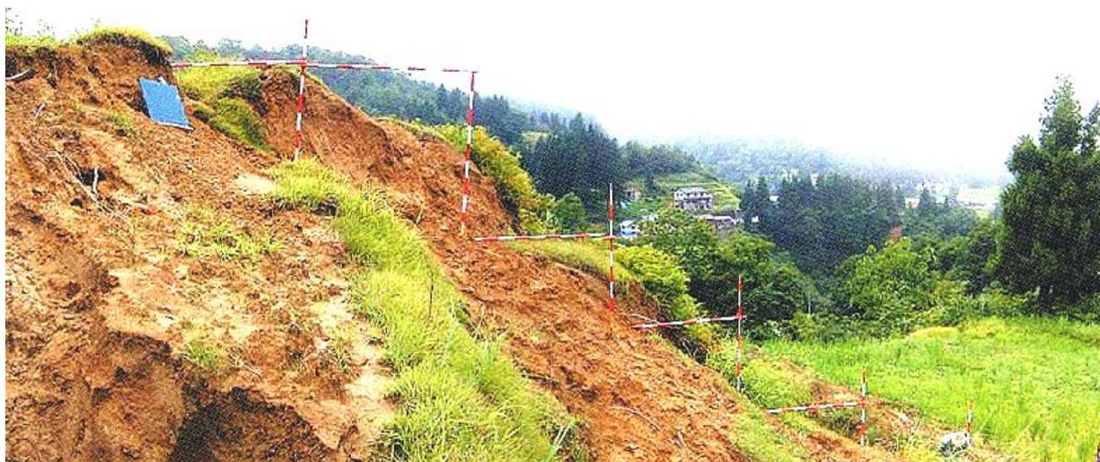
写真 1月9日の余震の増破で原形を止めなくなった小平尾地区の農道
