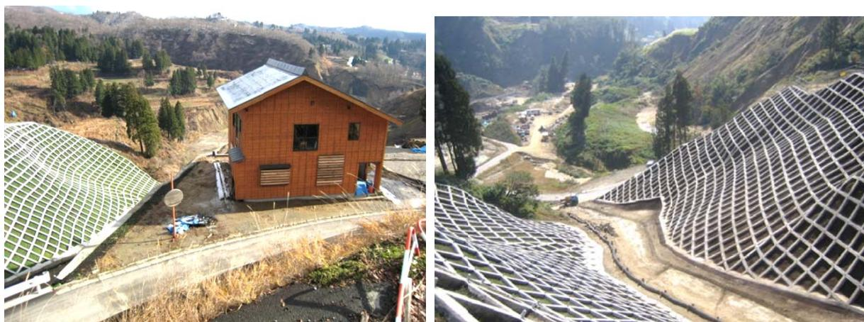
崩壊した法面の保護工事と曳屋をして修復した住宅（山古志・池谷地区：06.10）
