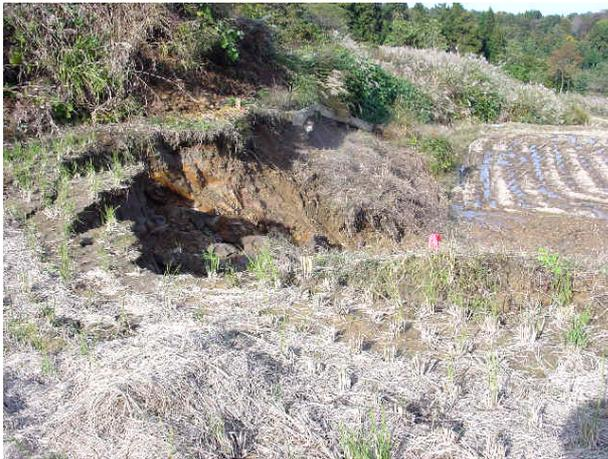
棚田の畦畔の崩壊／地震による亀裂・崩壊に加えて水の介在があったと思われる／山間地で、傾斜は 1/10 以上／04. 10. 31／小千谷市逃入
