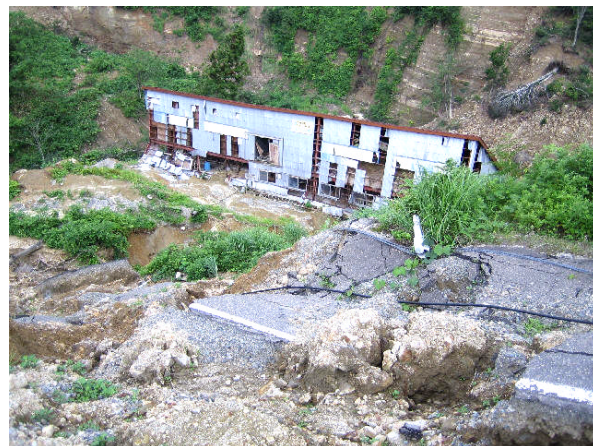
地震で芋川の水面にまで滑落した牛舎／牛舎は道路脇にあったが一瞬にして十数メートルの高度を牛と共に落下した／写真の道路面も元の位置から数メートル降下している／05. 07. 11／旧山古志村池谷・芋川上流部
