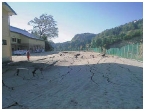
写真 陥没し亀裂が走る東山小学校グラウンド (市報おぢや 2004. 11. 10 号より引用)
