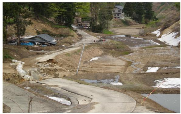
写真8 土砂が路面に堆積した道路と崩壊家屋
