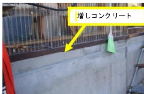
コンクリートによる水槽の補強
