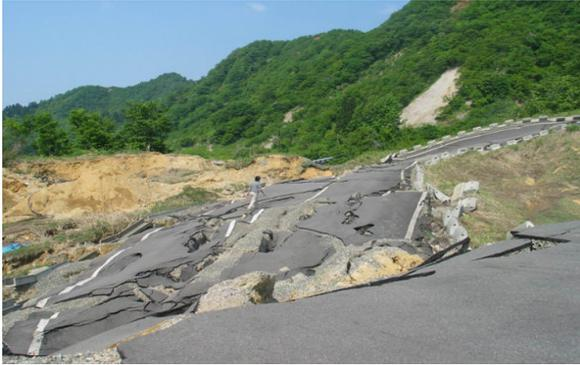
写真1 盛り度部分が崩壊した道路
