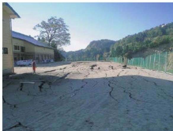
写真 陥没し亀裂が走る東山小学校グラウンド
