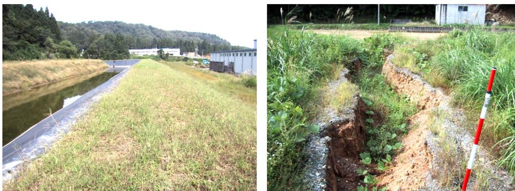
写真 被災状況が大きく異なった隣接する新旧のため池堰堤（小千谷市）
