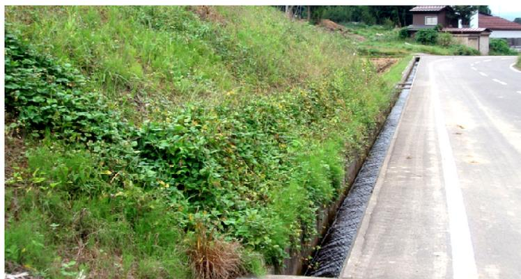
写真3 鋼製擁壁は短期の内に周辺植生に溶け込む
