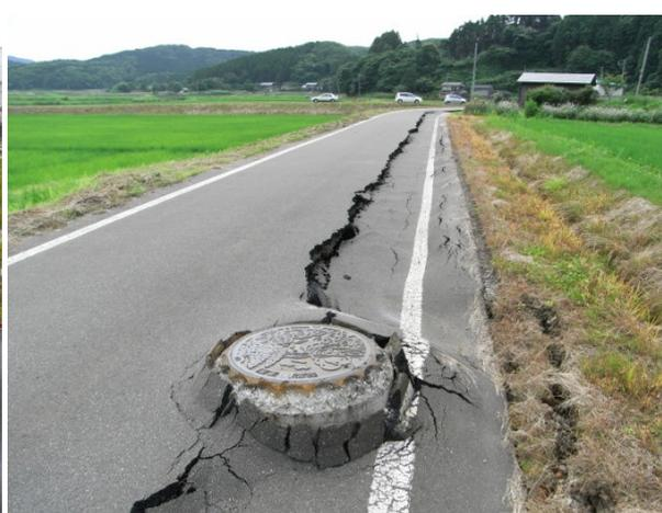
浮上したマンホールと埋設管渠に沿った沈下／
