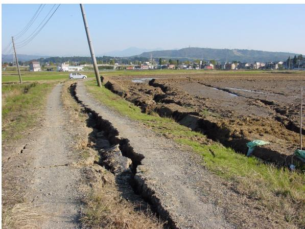
写真1 農地と道路が一体的に崩壊した(中越地震)
