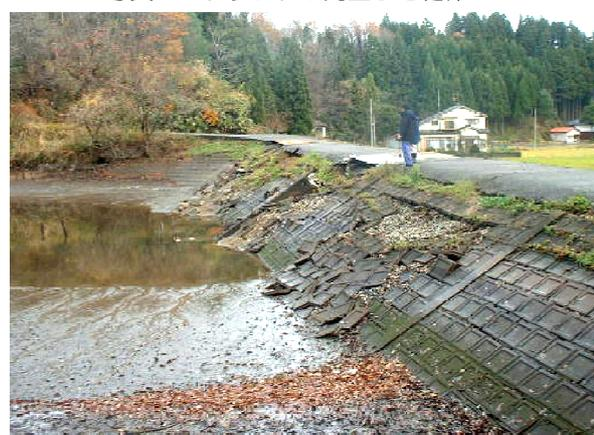
写真4 滑り破壊が発生した堤体
