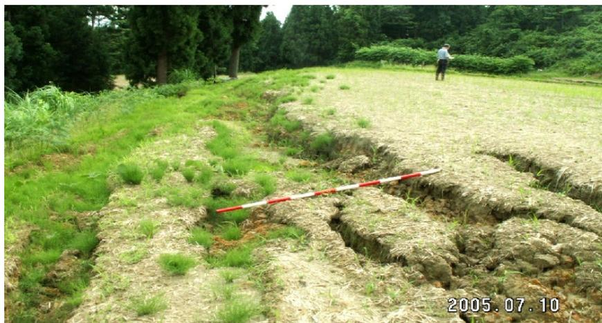
写真 地盤の亀裂は目視で確認できるものだけとはかぎらない(旧・山古志村池谷地区(2005))
