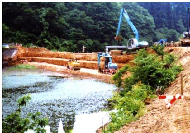
写真2 亀裂部のベンチカット(旧栃尾市)
