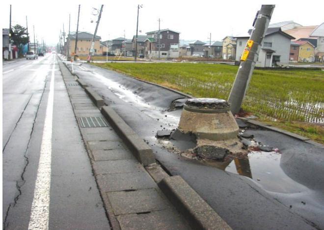
浮上したマンホールと埋設管渠に沿った沈下／04. 12. 11／
