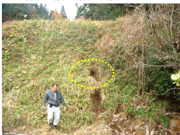
写真3 バイピングによる浸出水
