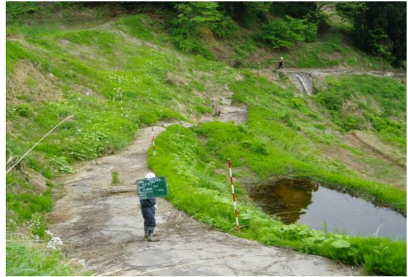
写真4 崩壊した山間地支線農道（コンクリート舗装）
