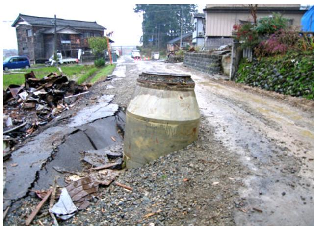
写真 1 市町村道に埋設されたマンホールの浮上
