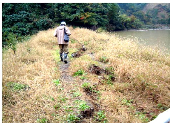
写真2 クラックが発生した堤体
