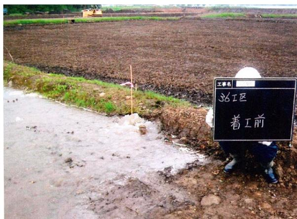
写真 通水時の漏水状況(中越地震)
