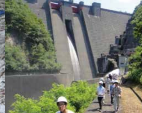
水資源の要、利水ダムの現地見学
